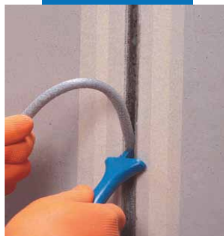
Укладка шнура Мапefoam вовнутрь шва
