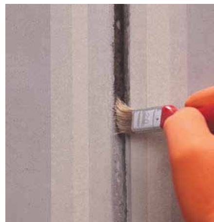
Нанесение Primer AS
